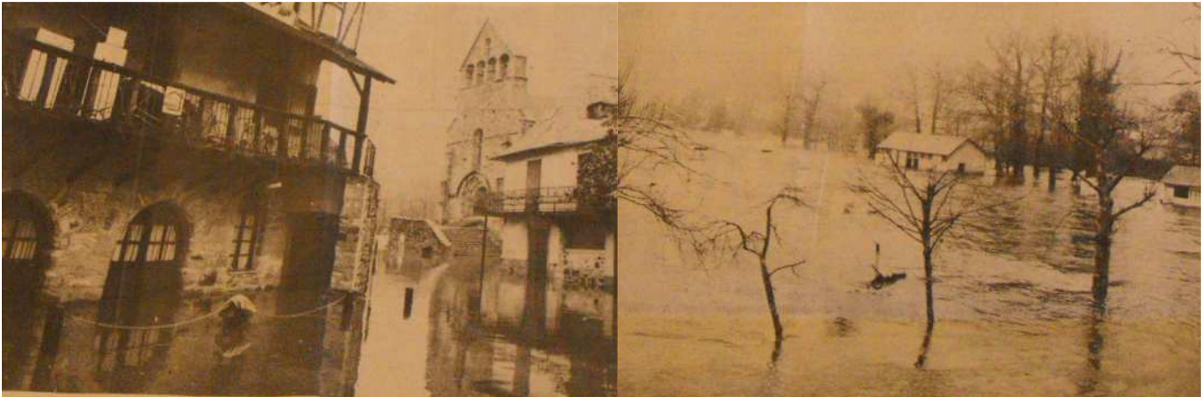
Fig. 13. Inondations à Beaulieu sur la Place de la Chapelle et au droit du Village vacance
